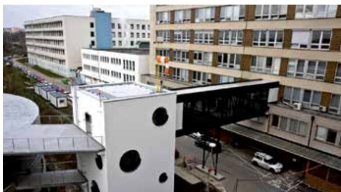
Príklad rekonštrukcie staršej budovy Fakultnej nemocnice v Plzni (ČR) – vstup do časti urgentnej medicíny si vyžiadala mimoúrovňový prístup do budovy zo strany heliportu.
