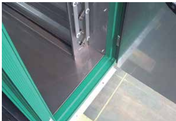
Vnútrotný povrch vetracej jednotky spĺňajúci hygienické kritériá na možnosť čistenia a prístupnosť
